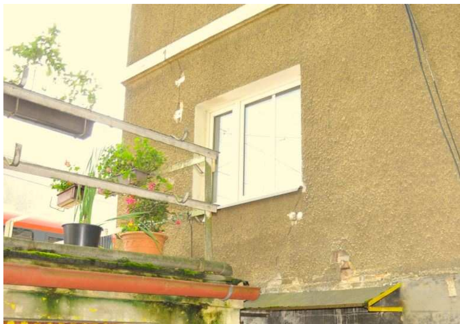
Obr.7– trhliny v S štítu
