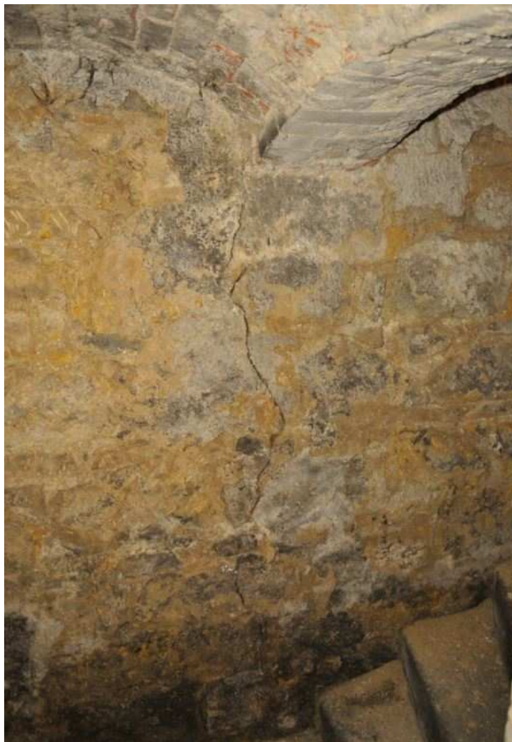
Obr.4– trhlina v J štítu-zdivo v 1.PP
