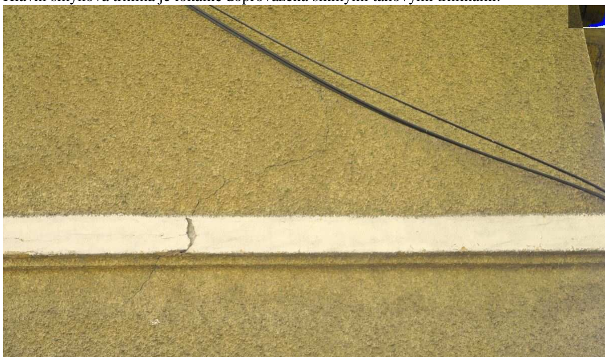
Obr.9– trhlina v S štítu
