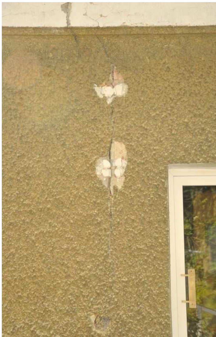
Obr.6– trhlina v S štítu
