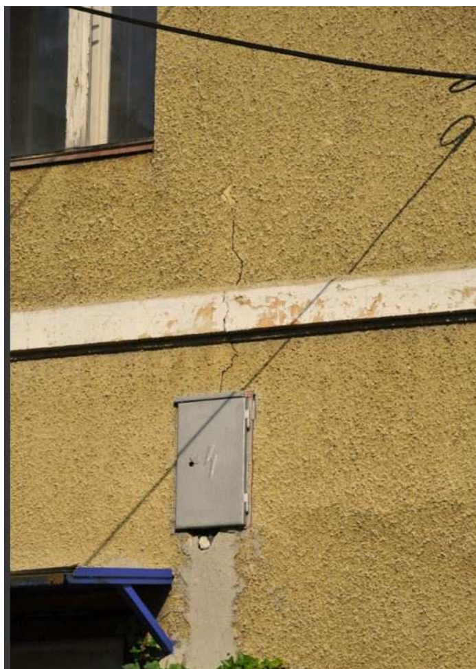
Obr.3– trhlina v J štítu
